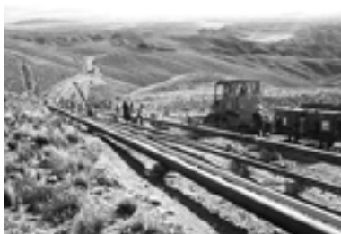
Tendido de gasoducto. "En la actualidad, Bolivia tiene una de las economías más sólidas del continente. En seis años se han construido más carreteras, escuelas y hospitales que en los últimos 50 años". Jorge Sanjines Revista N 23/3/2013
